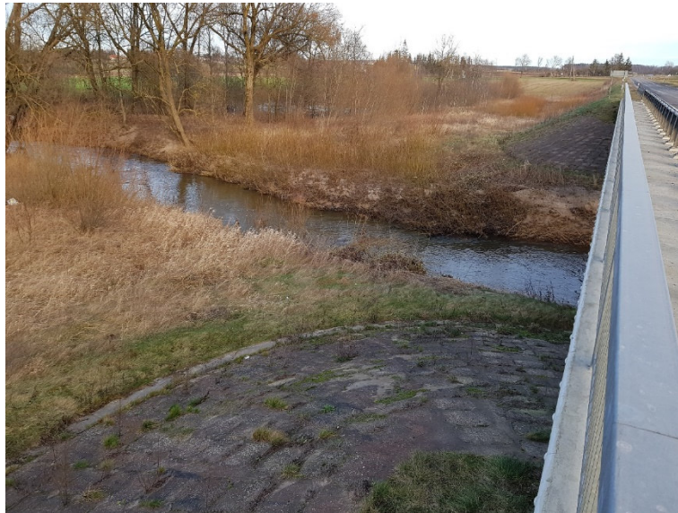
Pav. 3 Upė Luoba, projektuojamos pralaidos vietoje
